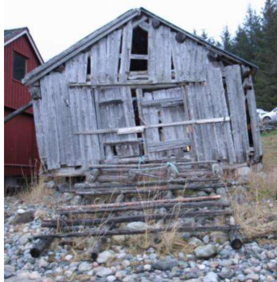
Fig . 228. Dette naustet står på Smines i Kolvereid kommune, Nord-Trøndelag fylke. Vi ser sperreverk, men i ei tidleg utforming; utover, grove tappar og snedband som epikar ned frå staven og mit sylla. Det er som i dei gamle skjelterskjåane i Nord-Noreg.
