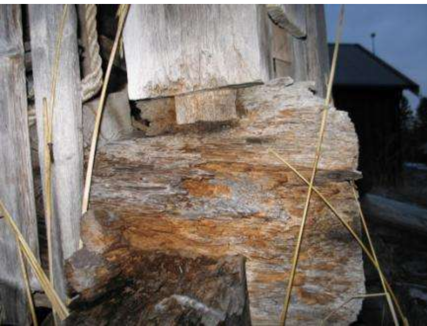
Fig . 228. Dette naustet står på Smines i Kolvereid kommune, Nord-Trøndelag fylke. Vi ser sperreverk, men i ei tidleg utforming; utover, grove tappar og snedband som epikar ned frå staven og mit sylla. Det er som i dei gamle skjelterskjåane i Nord-Noreg.
