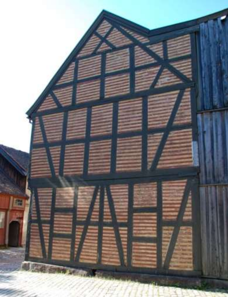
Fig. nr 120 B. Tollbugata 14 Oslo, no Norsk Folkemuseum er bygd i utmura bindingsverk , men ikkje etter dansk mønster som har fullstendig korrespondanse i vertikale delar og med jamlange fak. Roede reknar med at huset er frå ca 1700. (Roede 2001)
