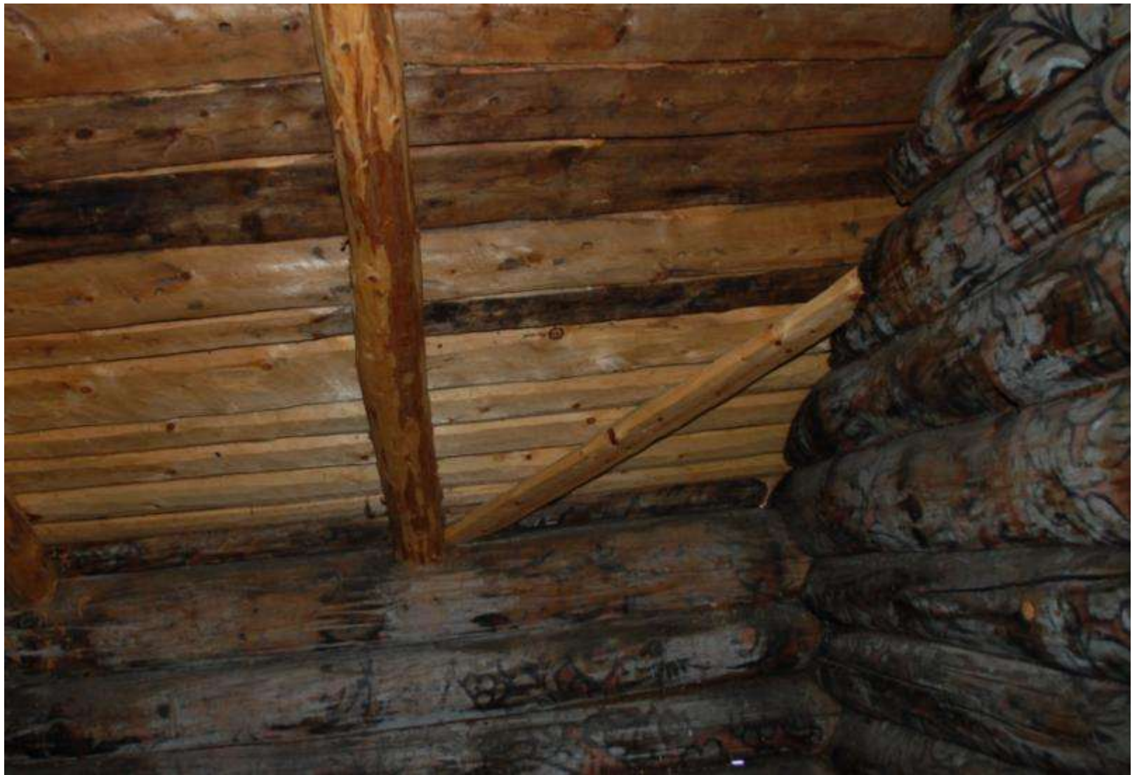
Strevar frå raft til røst i stabbur på Misvær Nedre, Misvær, Bodø kommune, Nordland.
