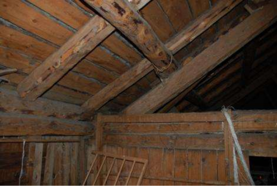
Fig. 186. Når vi kjem inn ser vi at det er eit fullstendig åslagt tak og med sperrer oppå. Åsane ligg på sperrebukkar. Dette minner mykje om Vest-Telemark, men det er dobbelt raft som på Nordmøre elles. Vi ser også den kraftig tømra i røstet. Vi tolkar dette som ein tilsikta måte for å gi vekt til bygningen. Bygget står godt jamvel i dei verste vindkasta.
