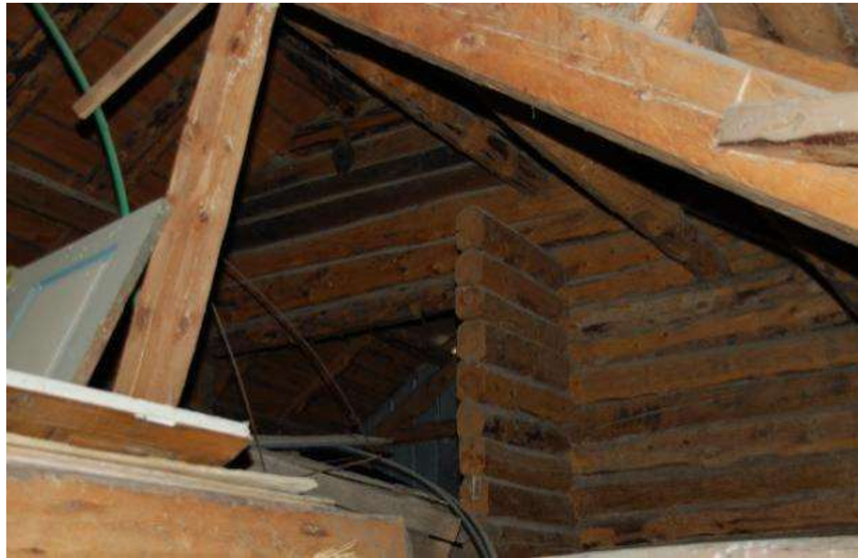
Fig. 186. Når vi kjem inn ser vi at det er eit fullstendig åslagt tak og med sperrer oppå. Åsane ligg på sperrebukkar. Dette minner mykje om Vest-Telemark, men det er dobbelt raft som på Nordmøre elles. Vi ser også den kraftig tømra i røstet. Vi tolkar dette som ein tilsikta måte for å gi vekt til bygningen. Bygget står godt jamvel i dei verste vindkasta.
