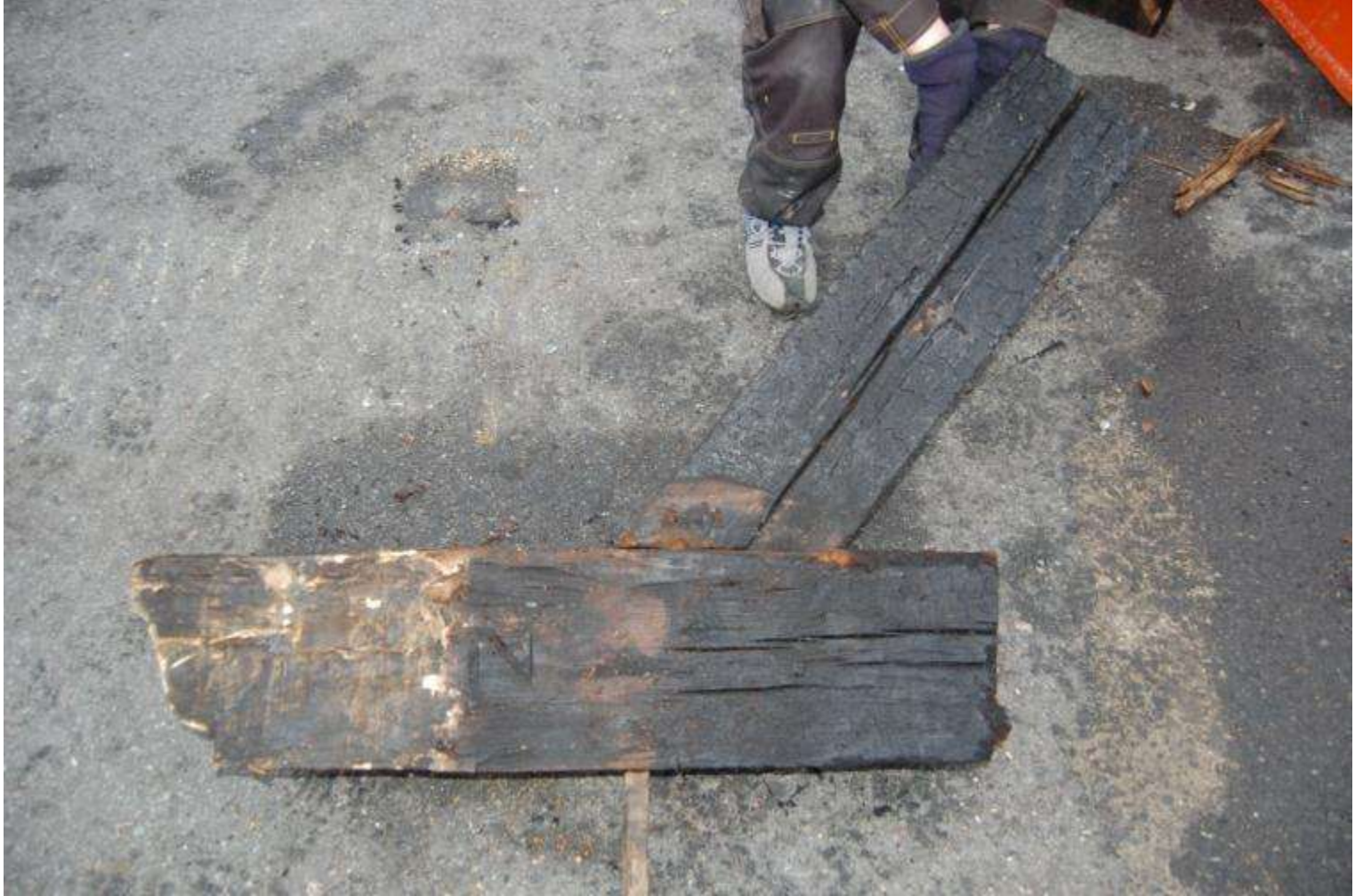
Lehmkulboden, detalj samanføyning sperr og sperrelunn. Det lyt til ein temmeleg stor oppskalk.
