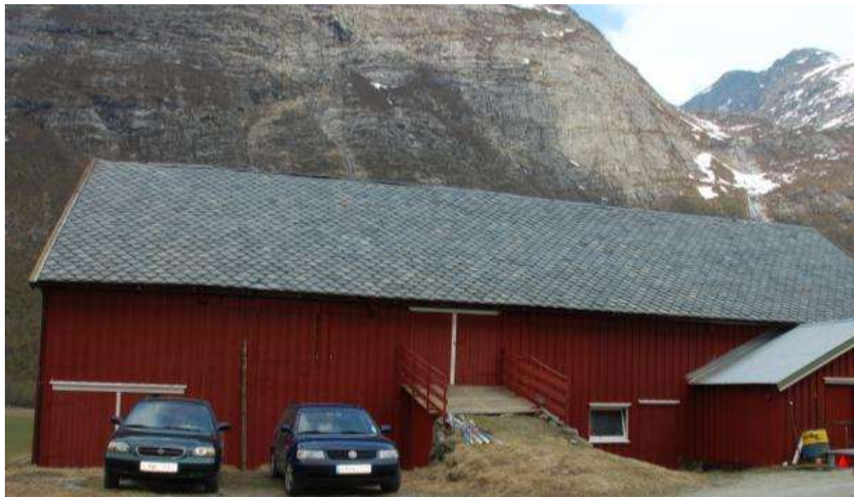
Fig. 185. Musgjerd ligg eit stykke opp i Sunndalen, Sunndal kommune Møre og Romsdal. Fjella på bortsida er bratte og kan gi fonnagufs , sterk vind av orkans styrke. I røstet ser vi at det er eit åstak vi har for oss.
