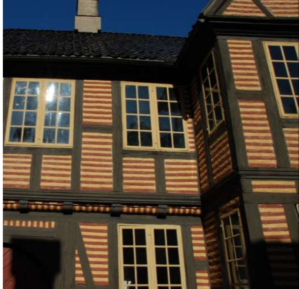
Fig. nr 120 B. Tollbugata 14 Oslo, no Norsk Folkemuseum er bygd i utmura bindingsverk , men ikkje etter dansk mønster som har fullstendig korrespondanse i vertikale delar og med jamlange fak. Roede reknar med at huset er frå ca 1700. (Roede 2001)
