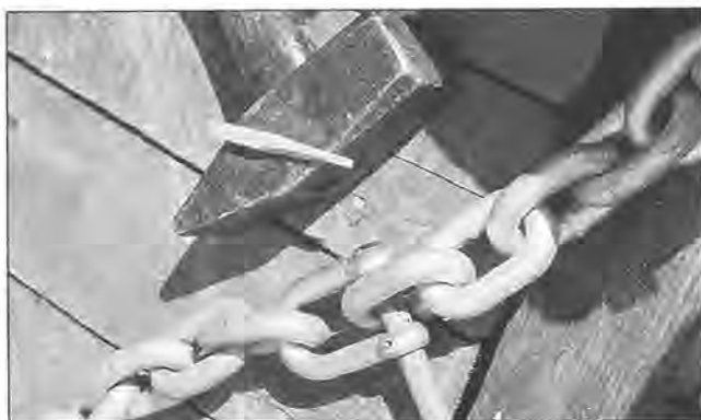
Ankerkjettingen er delt opp i lengder som er skjøta med sjakler. Boltane er ikkje skrudd, men klinka og sikra med treplugg av eik.
