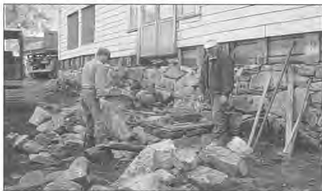
Det er gjennomført omfattande reparasjonsarbeid på hovudhuset på Håland. Til arbeidet med grunnmur og tropp leigde vi inn Rolf Arne Olsen og Torstein Vika frå Hjelmeland.
