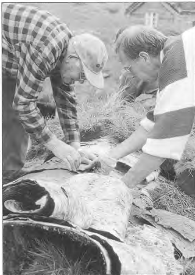
Bygningsvernkurset på Sandsa blei avslutta med takteking. Her lærer Mikkel Bratland bort til Jens Vestersjø korleis ein legg skjervingsnever på mønet. Ein hovudide i bygningsvernprosjektet har vore at ein gjennom konkret arbeid skal overføre kunnskap frå eldre tradisjonsberar til yngre handverkarar.
