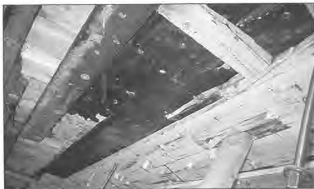
Då dei dårlege spanta var skifta, kunne ein ta til å skifte hud. Her ser vi den opphavlge klinkhuda, under nye plankar.
