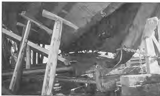
Det viste seg at kjølen til Brødrene var dårleg. Her er han lausna og klar til å bli løfta vekk.
