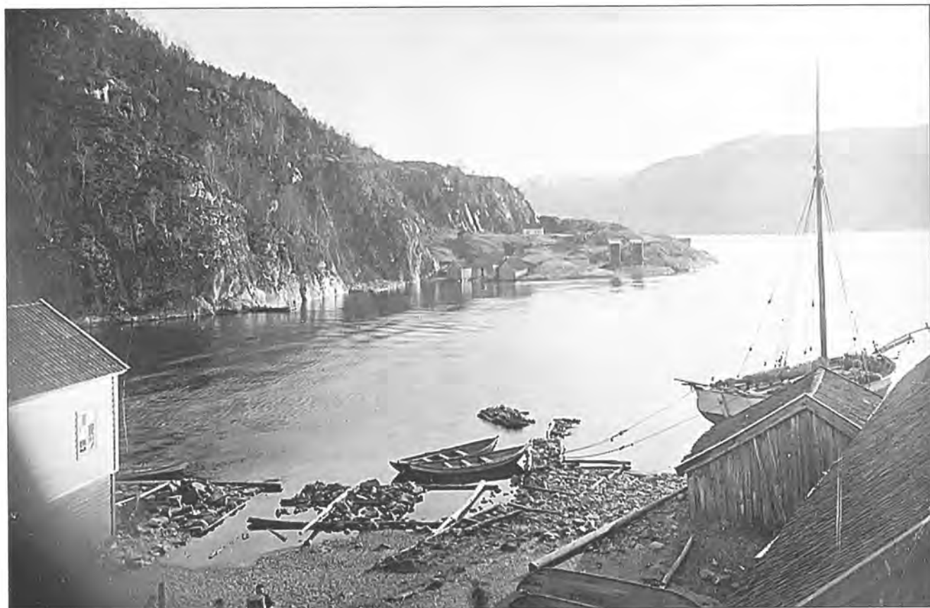
Dette bildet er teke tidleg på 1900-talet i elvaosen på Sand med husmannsplasset Fiskeberget i bakgrunnen, på sørsida av elva. På nord-sida av elvaosen var det tre strandsitjarstover. Det var hus som låg noko for seg i høve til strandstadbusetnaden elles. Jekteskipperen Hans Rolfsen og kona Anna bygde sitt hus i elvaosen ein gong midt på 1890-talet. Og Hans hadde jektå si «Boletta» fortøyd her når han var heime. Såleis er det truleg «Boletta» som ligg til høgre i dette bildet. Ifylgje opplysningar i familien skal jektå ha lasta 12 samner med ved meir enn «Anna af Sand». Hans Rolfsen gjekk både på Austersjøen og Nord-Noreg. Det kan elles òg ha vore jektå til Ola Torgersen Bakke som ligg i elvaosen. Jekteskipperen Ola Bakke budde oppe på Lågabrotet med familien sin, og hadde jektå «Haabet» fortøyd i elvaosen.
