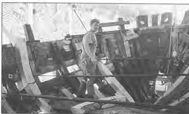
Båtbyggerane er i gang med å skifte spant. For å sikre fasongen på dei nye spanta, er den gamle huda framleis på. Det er montert AZ-stag for å hindre fartøyet i å endre fasong.
