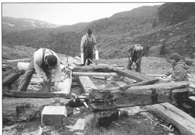
Kurs i restaurering av stavløe på Sandsa.
