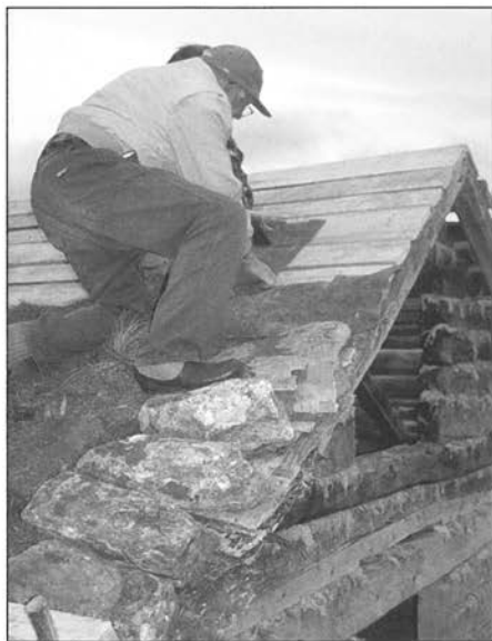
Never, torv og gavlasteinar vart lagt etterkvart som ein steig.
