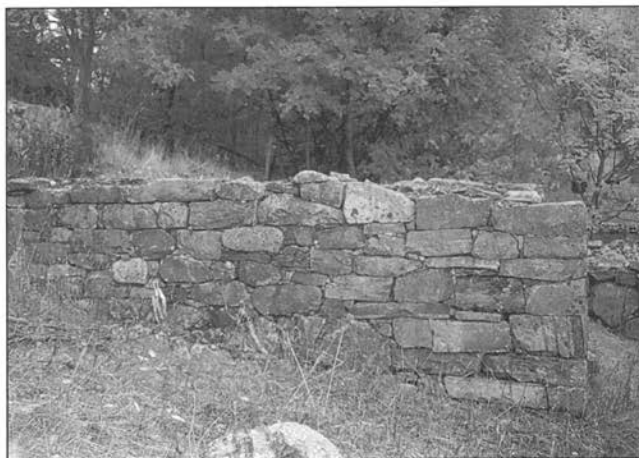
Murane på handelstaden i Hylen med lengdebindingar og skorer. Murane er lagt med urastein som er hogde til med sett.
