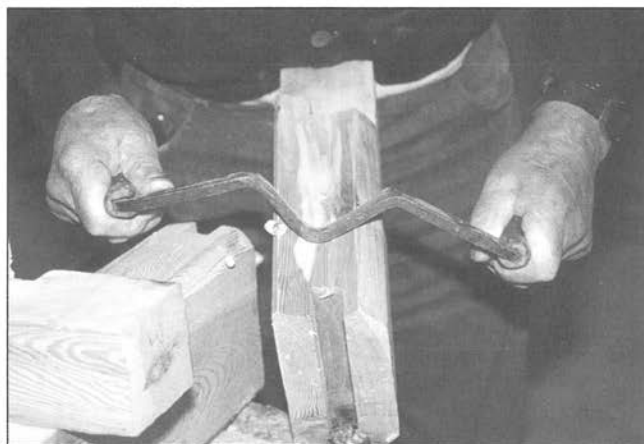
Suet vart grovøksa etter rissinga og finjustert med sukniven.
