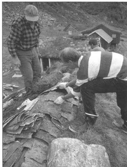
På mønet vart det lagt fleire lag med smånever før ein til slutt la skjervingsnevra.
