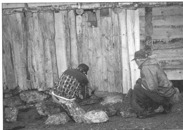
Det var brukt osp som kledning på gamlestølen på Sandsa. Kledingingen var nagla på neglingane med furunaglar.
