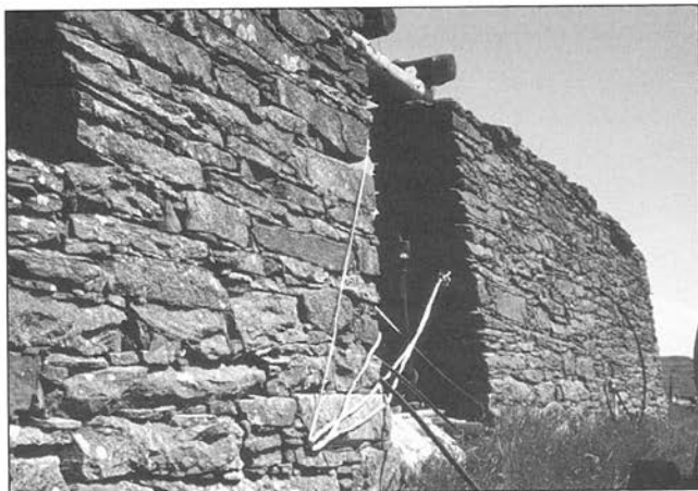
Muren i driftsbygningen på Førsvoll er bygd av ein blanding av fyllitt, amfibolitt og skifer.
