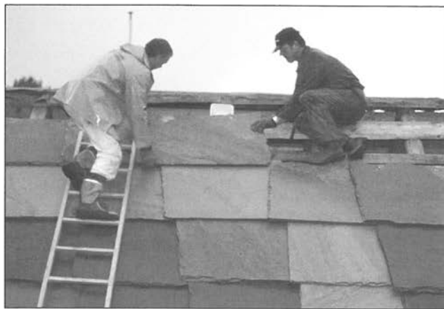
Lars Randa og Jan Bjørnstad legg helletak på nytt naust på Børøy.
