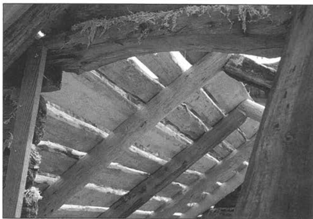
Tro vart lagt med vannkanten ned og retta opp.
