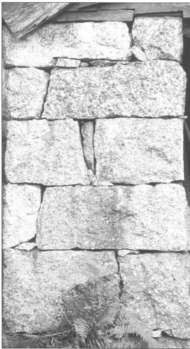
Mur på Gautun med tverrbindingar og skorer. Muren er av hoggen og kilt stein.
