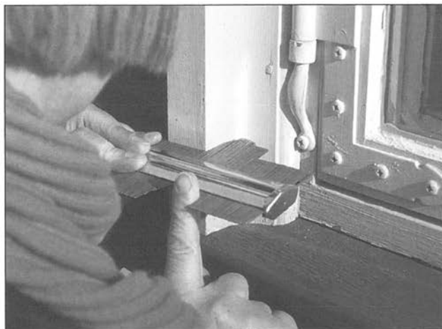
Det er registrert eit representativt utval av listverk med profilmålar.
