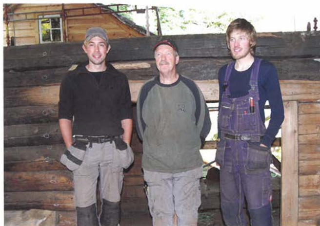
Som forsterking av staben til vurdering av tilstand og tiltak hadde me med oss handverkar, Magnus Wammen, frå Norsk Folkemuseum. Resultatet var at heile den lafta stova må ned for å få skifta ut dei nødvendige stokkane. Det blir ein vinter til under presenning.
