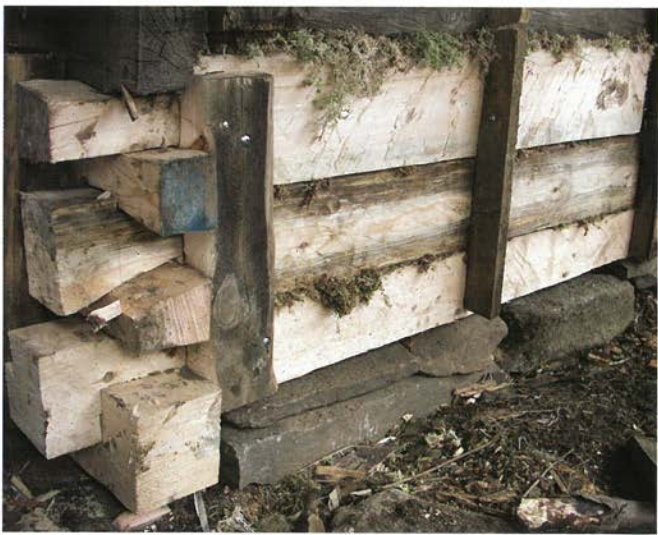
I nord-vestre hjørne er det no skifta tre stokkar i kvar vegg.
