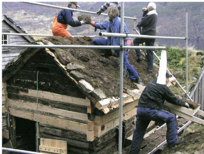
Det var eit godt dugnadslag som fekk tekka taket med never og torv.
