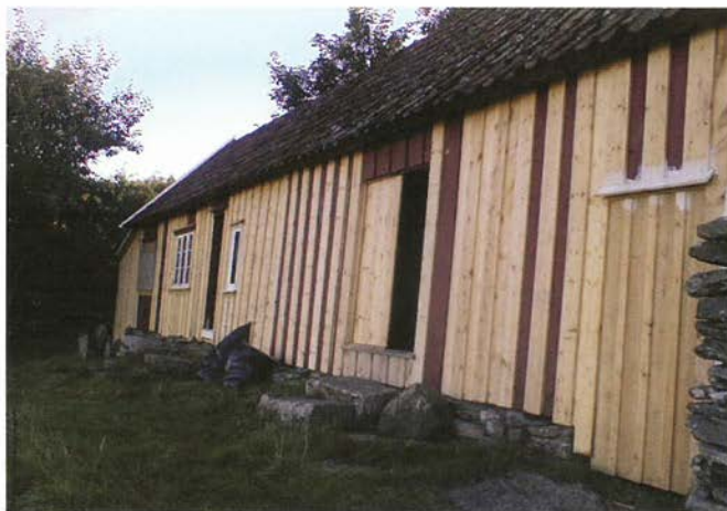
Dårlege bord vart skifta, medan gavlen mot sør vart kledd med ny stu i stu kledning. Foto Jarl Styve.
