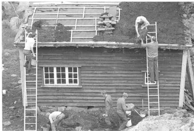
Det meste av aktiviteten opp gjennom åra handla om å halde husa i stand. Her er det tokedugnad på nystova i 1981. Det var den gongen vi ennå brukte grunnmursplast under torva. Det har vi slutta med.
