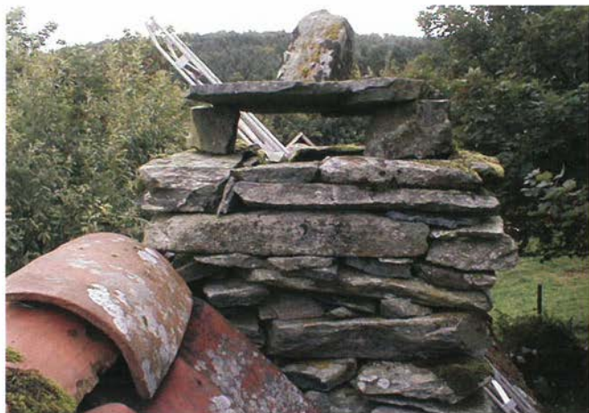
Pipa vart tatt ned til overkant tak og mura oppatt med leirmørtel. Foto Jarl Styve.
