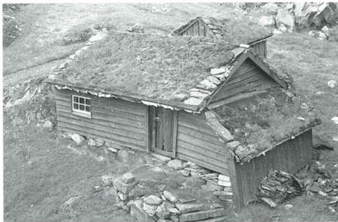
Gamlestova reknar vi med er frå 1834, då den første huslyden flytte til Røynevarden. Det er ei røykstove utan loft og skorstein, der røyken slapp ut gjennom ein ljore i mønet.
