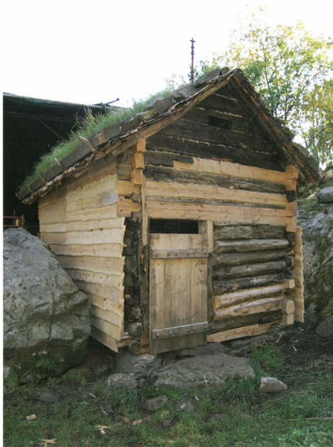
Sauhuset ferdig restaurert hausten 2007.
