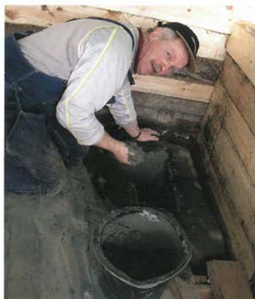
Kjell Johnsen pussar pipa innvendig frå lemmen og ned, og frå lemmen og opp etter kvart som pipa vert mura opp att.
