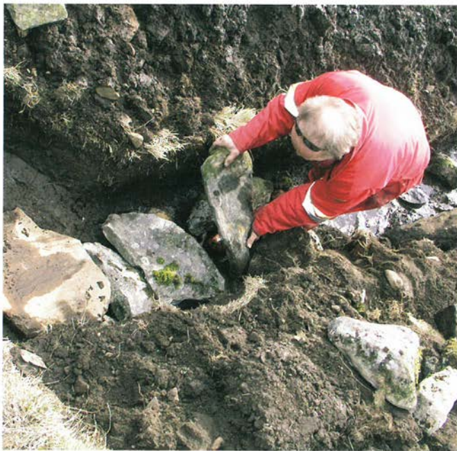
Jostein Tveit legg steinsett kistegrøft frå kjellaren og eit godt stykke ned bakken.
