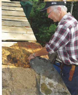
Taket blir tekka med never og torv. Her vert det lagt godt med never under torvhaldtreet. Me ser Birger Sandvik i arbeid, saman med museumshandverkarane.
