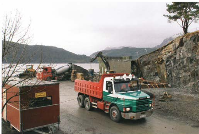
Etter 10 års planlegging og finansiering kunne vi starte arbeidet med reising av nybygg i oktober 2007. Meste av hausten gikk med til utsprenging av tomta. Bygget skal stå ferdig til jul 2008.
