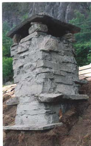
Ferdig pipe med utkrager og god tetting med bly, never og torv.
