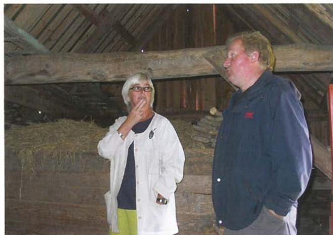
I 2004 vart byggmeister Jarl Syve engasjert til å gjera større vedlikehaldsarbeider på Bakke. Her er me må synfaring i 2005 for å vurdere det som er gjort og mulege nye tiltak.
