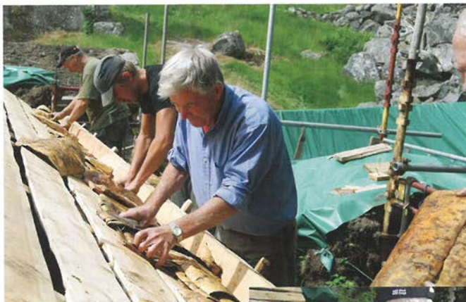
Taket blir tekka med never og torv. Her vert det lagt godt med never under torvhaldtreet. Me ser Birger Sandvik i arbeid, saman med museumshandverkarane.
