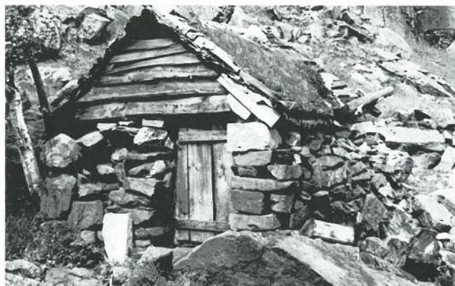
Eldhuset i 1946. Legg merke til at bordkledninga er ukanta. Foto: Riksantikvaren.
