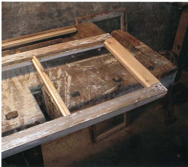
Glasa vart tatt ut, skrapa og reinska for mailing og kitt. Så vart dei dyppa i linolje, kitta og måla. Dette er eit tidkrevjande arbeid. Foto: Jarl Styve.
