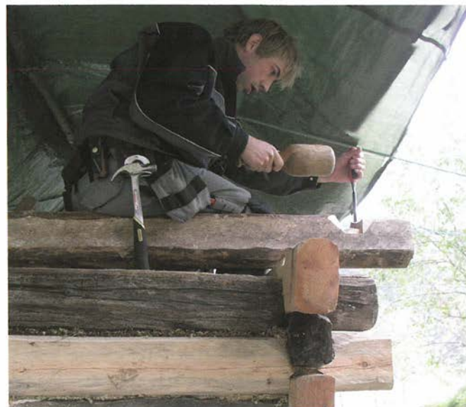
Prinsippet er å ikkje fjerna meir enn høgst nødvendig av stokkane. Likevel vart det skifta ut ein heil del.
