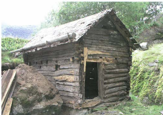
Sauhuset i 2006 etter at me hadde fjerna borkledninga på alle fire sider. Her ser me at det ein gong er øksa i tømra for å retta av for kledning. Dette kan tyde på at huset opphavleg ikkje har hatt kledning på desse sidene.
