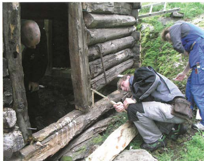
Rotne stokkar vart skifta ut. Med fare for å ikkje få satt oppatt huset, vart arbeidet gjort utan at huset vart tatt ned.
