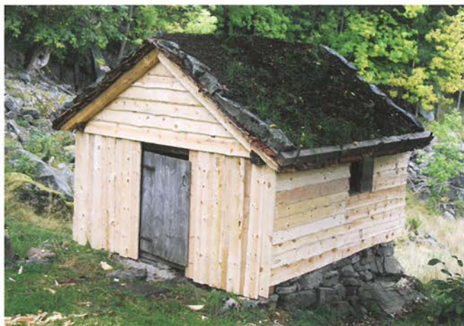
Det ferdig restaurerte geithuset
