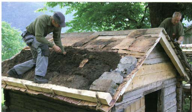
Det vart lagt nytt tro, never og torv også på geithuset.
