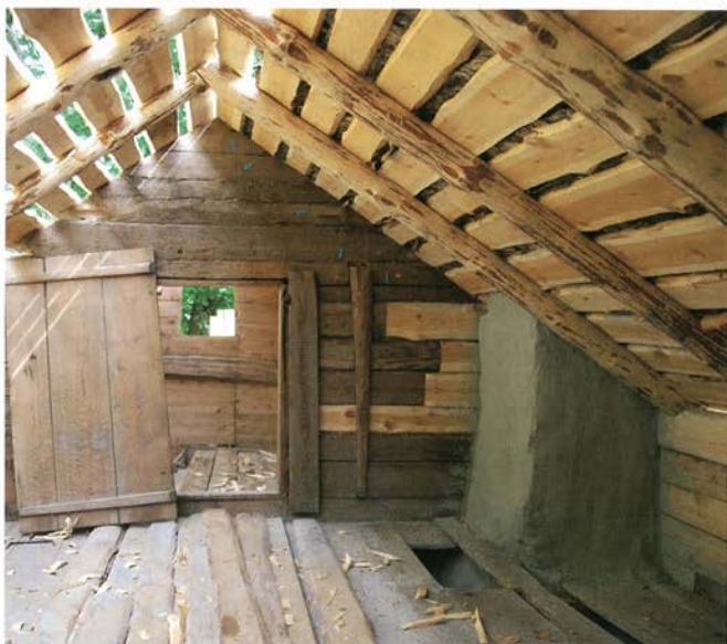
Lemmen etter restaureringa i 2008. Her er skifta stokkar enkelte stader ned til golvet. Novrekka bak pipa er ny. Det same er sperr og tro.
