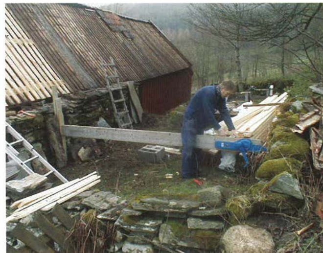
Heile taket mot aust vart lagt om. Dei gamle overliggarane vart skifta ut, og den gamle pappen fjerna. For å kunne nytta opp att dei gamle teglpannene, vart det lagt sutaksplater oppå dei nye overliggane. Foto: Jarl Styve.
