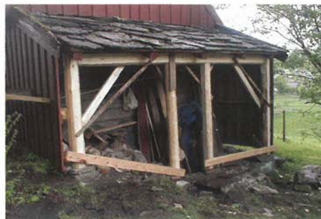
Heile reisverket i stavkonstruksjon måtte fornyast i skuten. Foto: Jarl Styve.
