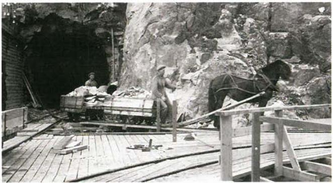
Tonnevis av stein vart transportert ut med hest frå tunnelane. Med skinnegangar og vogner (vaggar) gjekk arbeidet lett. Lokomotiv drivne av pressluft (compressed air locomotive) vart også teke i bruk. Foto: Sauda Lokalarkiv.
