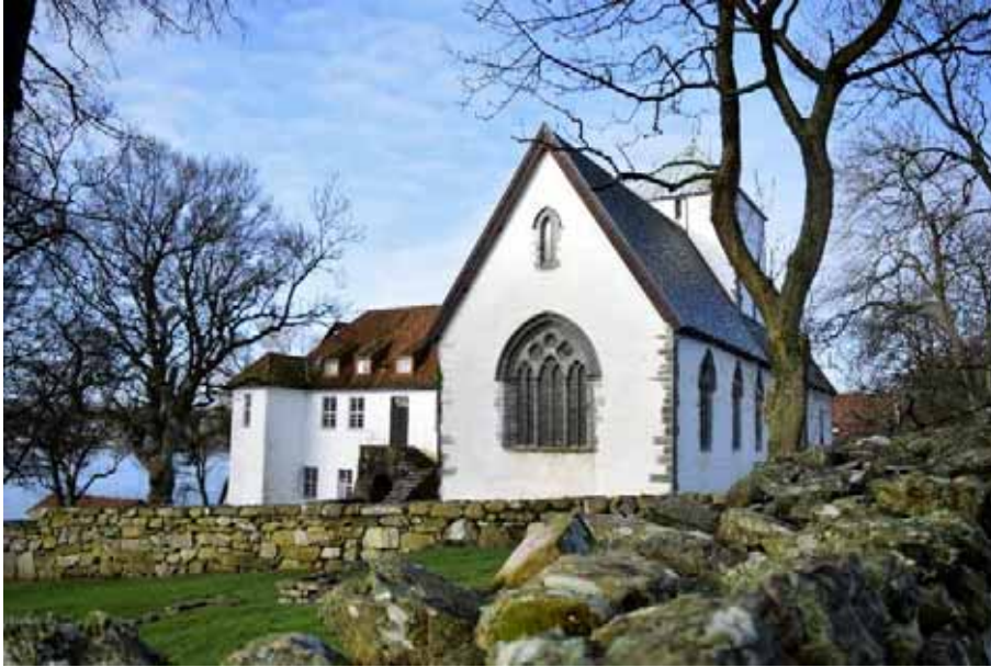
Figur 90 – Utstein kloster består av fleire bygningar/fløyer. Kyrkjefløy (nordfløya) er vurdert til tilstandsgrad 2.
