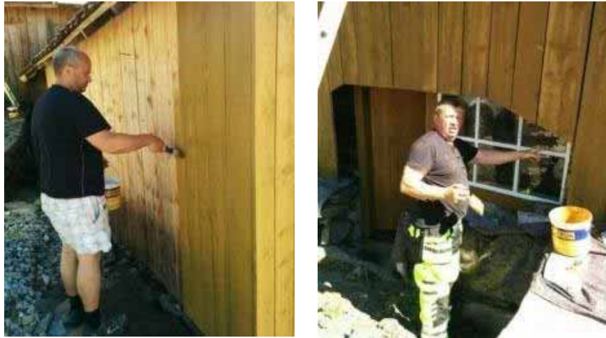
Figur 130 og figur 131 – Haugalandmuseet kokte komposisjonsmåling og måla uthusbygningane på småbruket Veien i Nedstrand. Fargeundersøkingar som blei gjorde på den gamle kledningen, viste at det hadde vore brukt nettopp komposisjonsmåling her.
