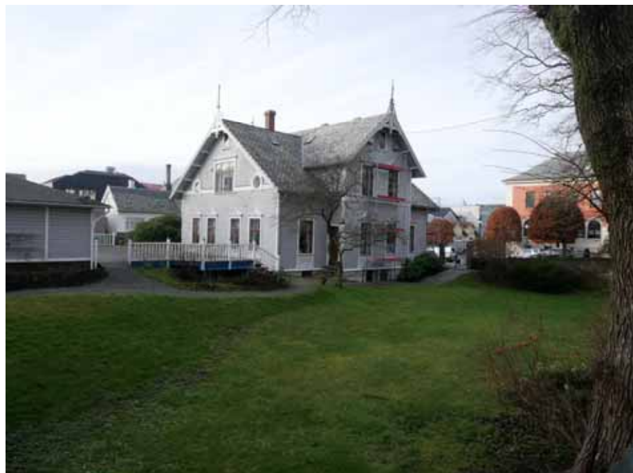
Figur 33 – Wrangellhuset er ein staseleg reiarvilla som museet overtok i 2017.
