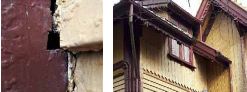
Figur 134 og figur 135 – Målinga var tidlegare påført i tjukke lag (jf. dropene på kledningsborda). Det viste seg naudsynt å skrapa ned til dei inste laga før dei målar opp igjen veggen med linoljemaling. På biletet til høgre er den ståande kledningen skrapa ned. Her blei det i 2019 måla prøvofelt.
