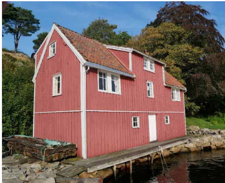
Figur 60 – Det gamle sjøhuset Hadlands Minde på Hovland, Eigerøy, blei bygd i 1826 og gjeve til Dalane Folkemuseum i 1978.
