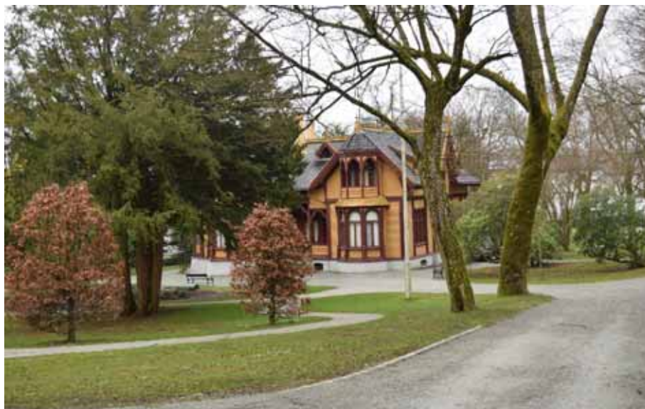
Figur 91 – Breidablikk er vurdert til tilstandsgrad 3.
