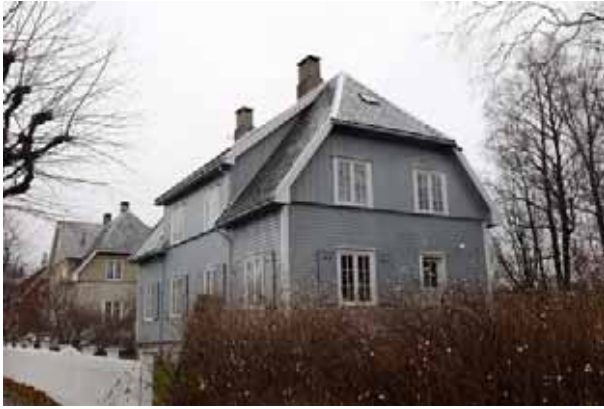
Figur 24 – Haakongsgate 51–53 i Sauda er ein industriarbeidarbustad bygd av smelteverket i 1916. Huset blei gjeve til kommunen med tanke om å få til eit industriarbeidarmuseum. Museet blei kopla inn og starta arbeidet med å setja huset i stand.
