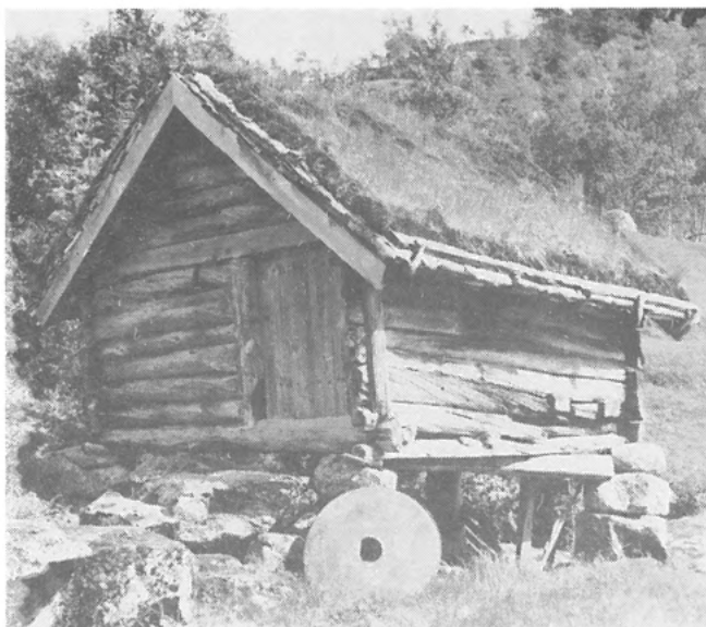
På Hjorteland har museet eit kvernhus og eit turkehus som er sette opp av lafta tømmer.
