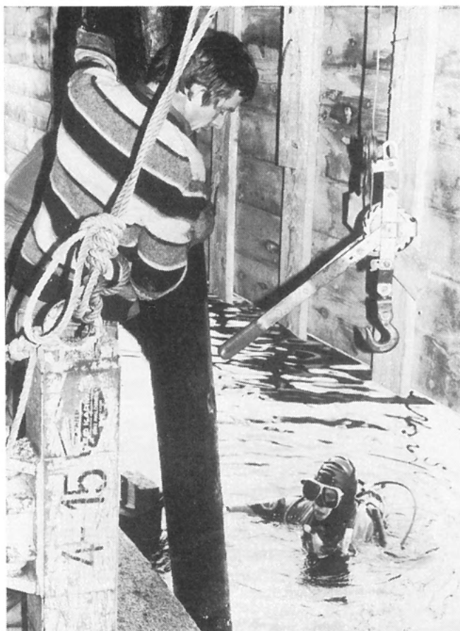
Dykkerhjelp var nødvendig da fundamentet for Nesa-sjøhuset skulle repareres. I vatnet: Ola Bråtveit, på land: Helge Husevåg.
