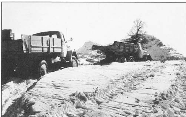
Dei første hjulgående kjøregreiene er komne opp til Neiken, der heia opnar seg med Grønhåve og Gullingen. Enno er det veglaust, men med hjelp av hestekrefter på godt snøføre greidde dei det. Den eine drog den andre i eit tog med tri vogner. Ulla-Førre-utbygginga skal ta til for alvor.
