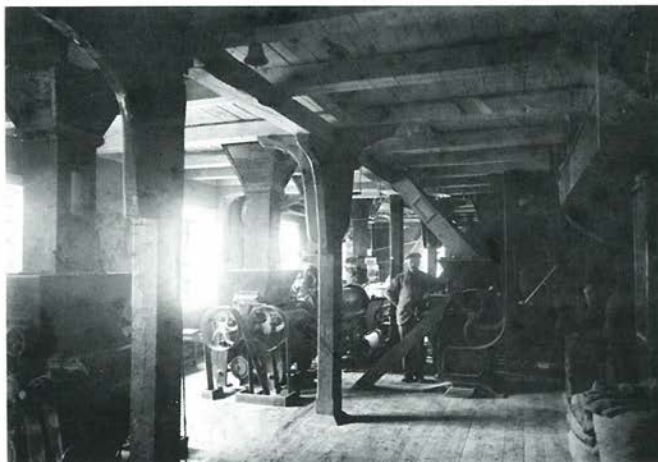
Dei første valsestolane ved Tou Mølle. Vi ser at dei har reimdrift. Valsestolar erstatta etter kvart kvernsteinane i mølleindustrien. I ein valsestol vert kornet mole ved at stålvalser dreiar mot kvarandre. Ved bruk av valsestolar kunne det produserast meir og finare mjøl ut av kornet. Foto frå Statsarkivet.
