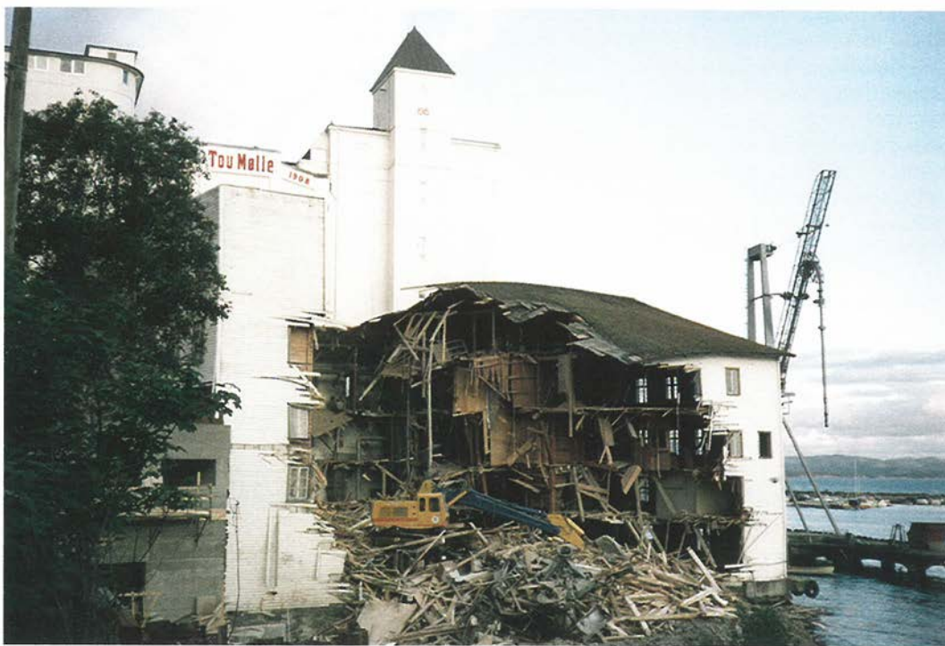
Riving av den gamle møllebygningen på Tau. Bygningen vart brukt til fôrblenderi frå 1954 til 1985. Foto: Kåre Tjøstheim.
