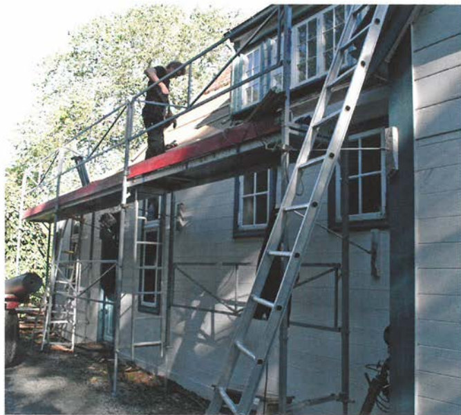
AS Ryfylke Trelast er i gang med å skifta tak på Villaen.
